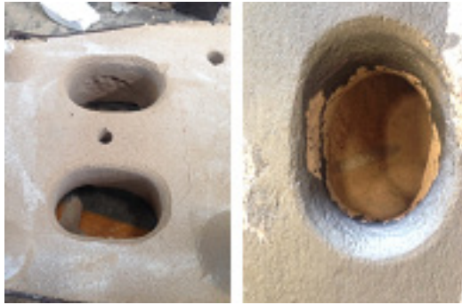
รูปแสดงลักษณะของส่วนขยายรูล้นหรือส่วนขยายฐานรูล้น
